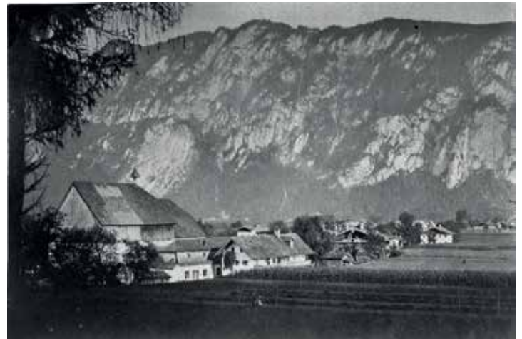
Das ehemalige Eisenhammerwerk Kiefer in einer Aufnahme aus der Zeit um 1885.
