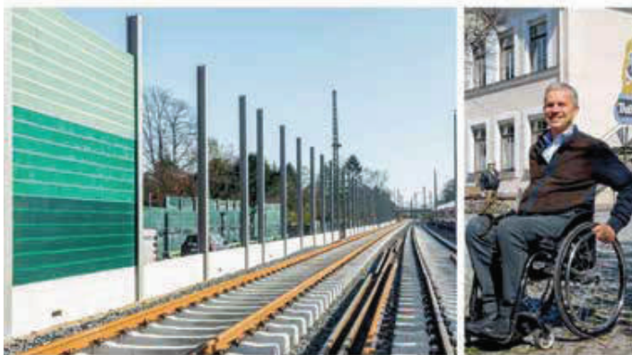
Der Kiefersfeldener Bürgermeister Hajo Gruber freut sich, dass die Schutzwände und Schienendämpfer entlang der Bahnstrecke fertig gebaut sind. © dpa (Scholz)/Ammelburger
