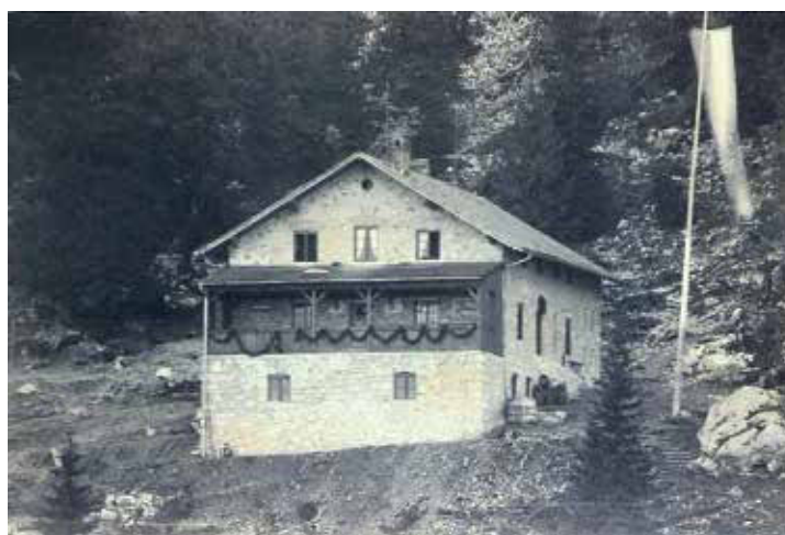
„Wie ein Schlösslein liegt das Haus an den Felswänden des Brunnsteins...“ - Die Eröffnung des Brunnsteinhauses fand am 12. August 1894 statt. Aus diesem Jahr stammt auch die abgebildete Aufnahme.
